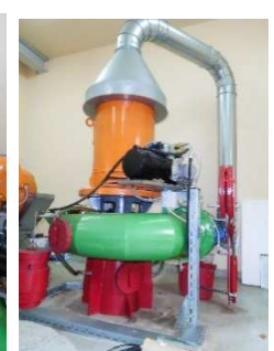
図 8：親子 2 代で経営するプライベートな小水力発電所(3 台のフランシス水車)、400V→22kV 変換
