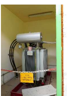
図 8：親子 2 代で経営するプライベートな小水力発電所(3 台のフランシス水車)、400V→22kV 変換
