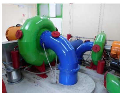
図 8：親子 2 代で経営するプライベートな小水力発電所(3 台のフランシス水車)、400V→22kV 変換
